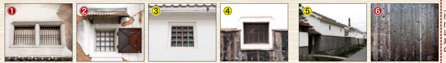
高田酒造土蔵窓 清水庵土蔵窓 赤瓦二号館土蔵窓 桑田醤油醸造場土蔵窓 玉川沿いの白壁土蔵 杉焼き板の縦目板張り
